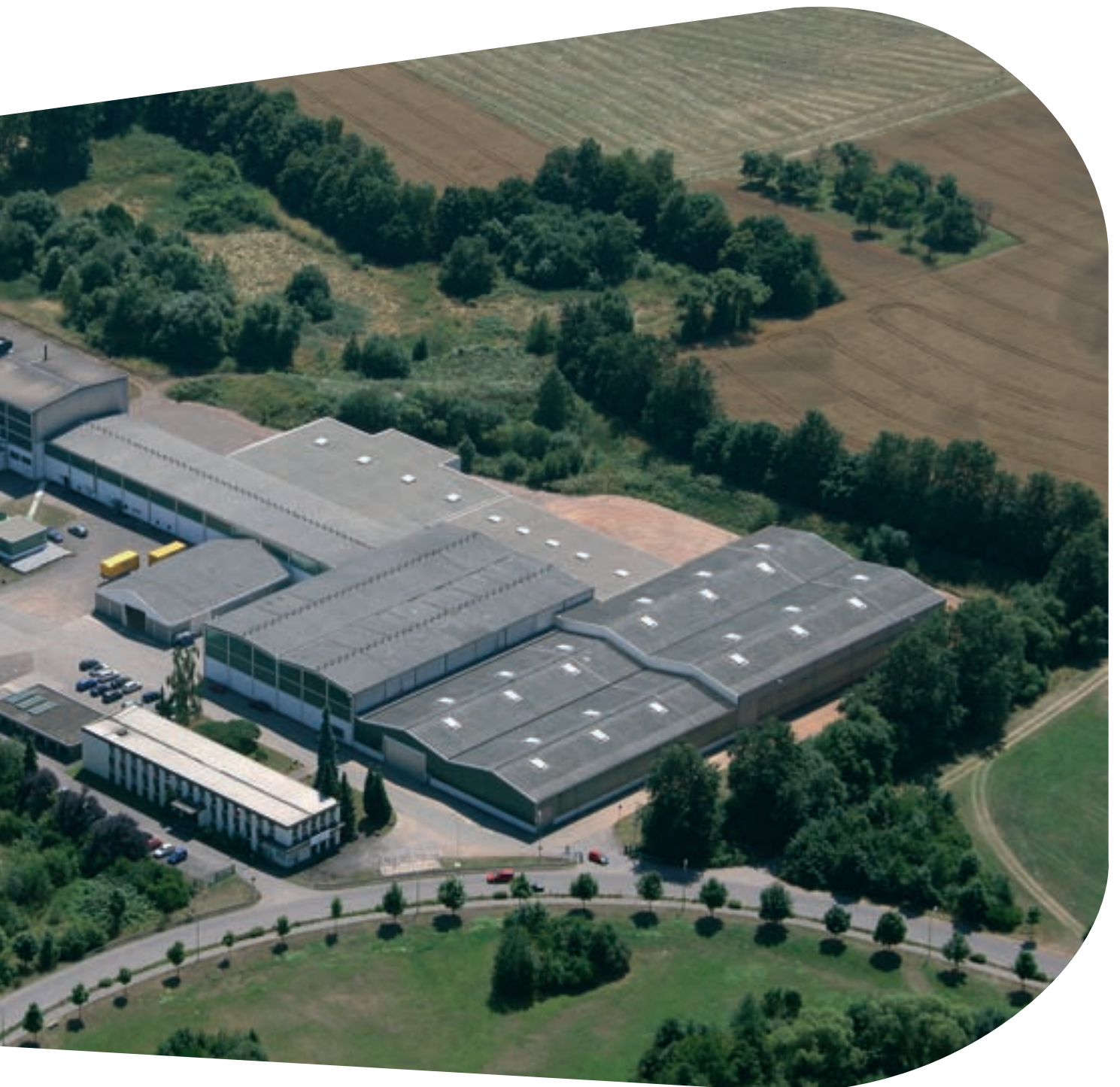
Bauglasindustrie GmbH, Schmelz
