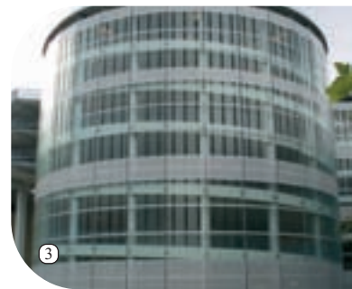
③ ④ EKZ-Alstertal (centro comercial) Aparcamiento, Hamburgo-Poppenbüttel Arquitecto: Architekturbüro Knut Jensen, Nordwalde
